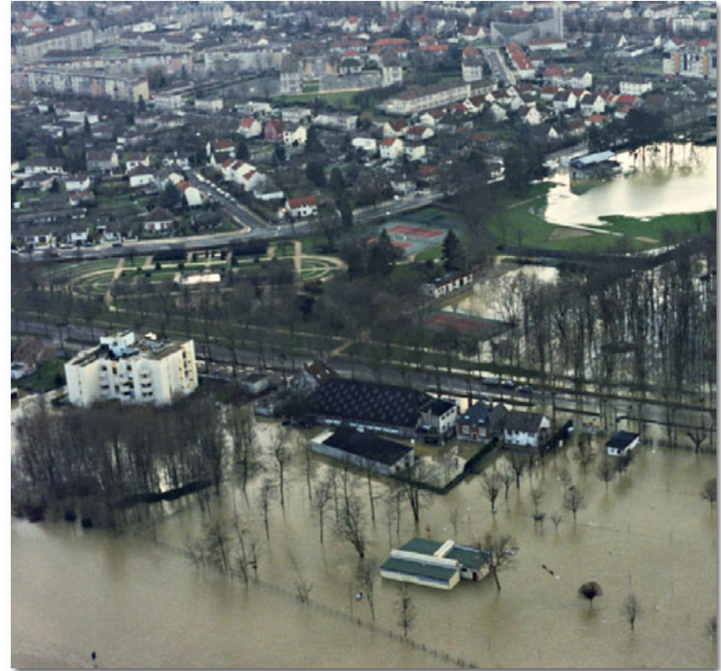
L'Aisne à Soissons (02), stade et piscine Saint-Crépin (photo Bernard Houdry – 26/12/1993)
