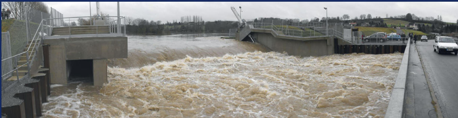
Grâce à la régulation de la crue du 7 janvier 2011 par l'ouvrage de Proisy, les dommages évités à la société sont estimés à 70 millions d'euros (photo Entente Oise-Aisne )
