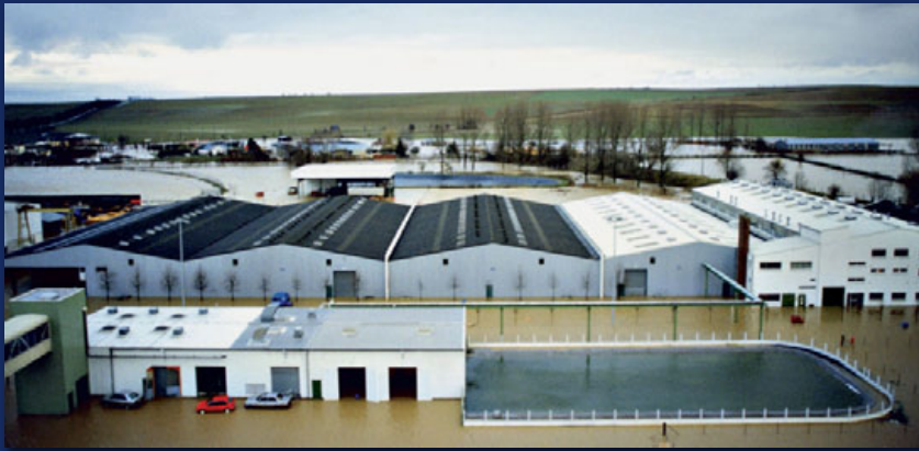
La Serre, zone industrielle à Marle (02) (Hydratec)
