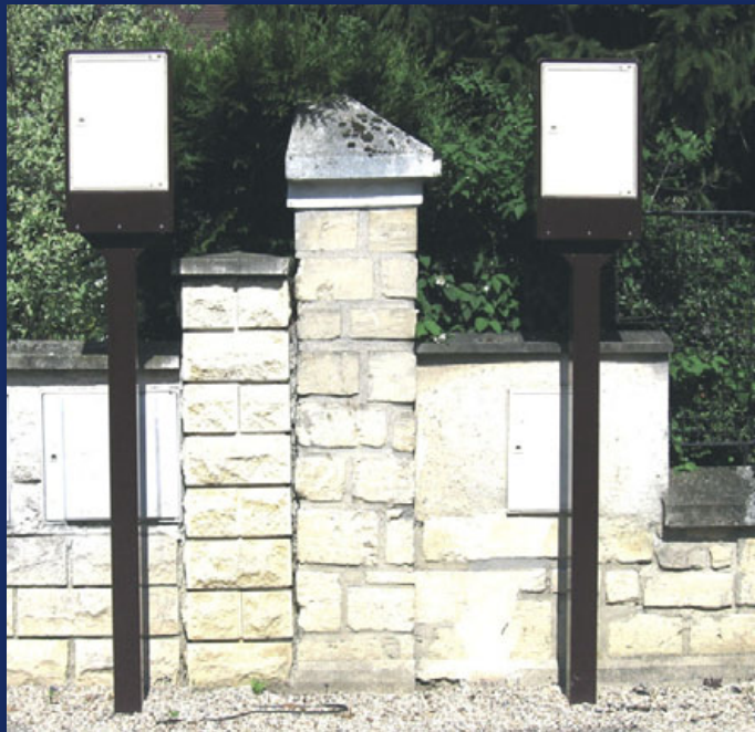
Chaudière et boîtiers électriques rehaussés à Jouy-le-Moutier (95) (Photos Entente Oise-Aisne)
